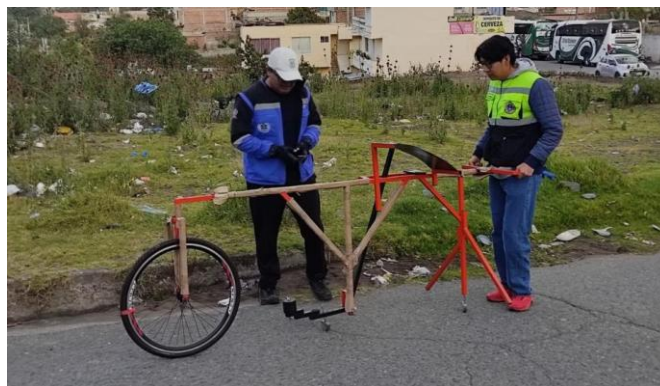
Figura 8. Ubicación del equipo en el carril de avance
