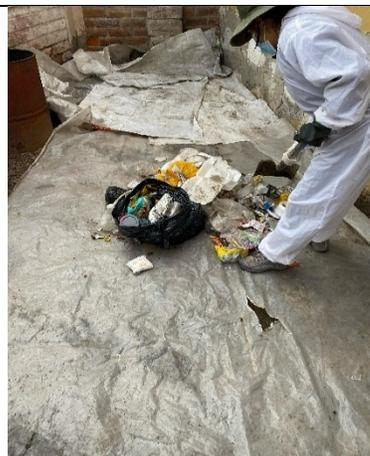
Fotografía 4: Homogenización de RSU.
