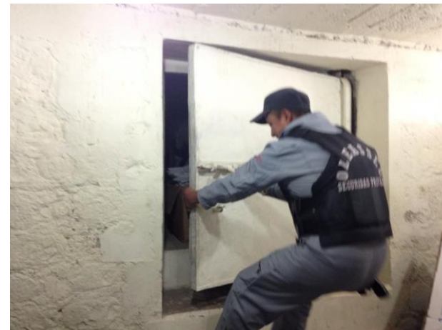
Bóveda de seguridad en subsuelo
