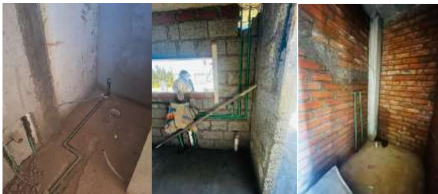
Anexo 9. Recolección de datos en instalación de agua fría mediante termofusión
