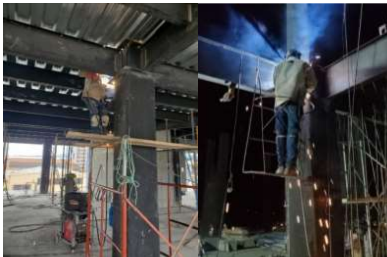
Anexo 15. Recolección de datos UNACH campus norte del montaje de acero estructural en vigas – filete de soldadura
