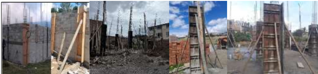
Anexo 8. Recolección de datos sobre el vertido de hormigón en columnas
