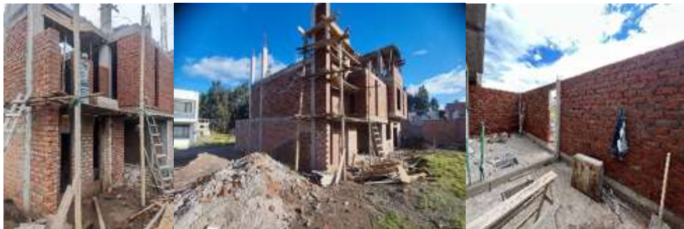
Anexo 5. Recolección de datos mampostería de ladrillo macizo
