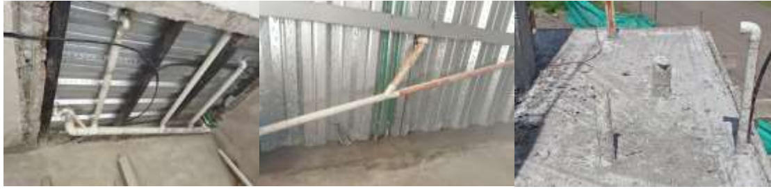
Anexo 10. Recolección de datos en instalación sanitaria de baños
