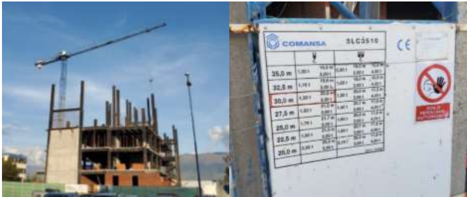
Anexo 16. Recolección de datos UNACH Grúa torre flat-top de 30,0 m
