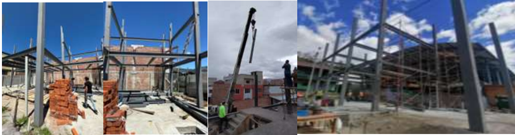
Anexo 11. Recolección de datos del montaje de acero estructural en columnas y vigas
