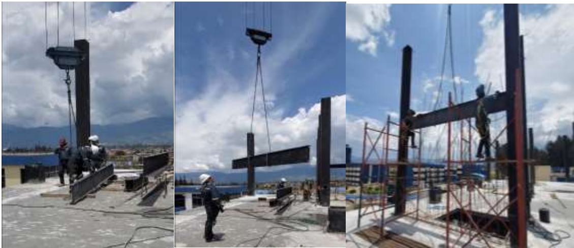
Anexo 14. Recolección de datos UNACH campus norte del montaje de acero estructural en vigas
