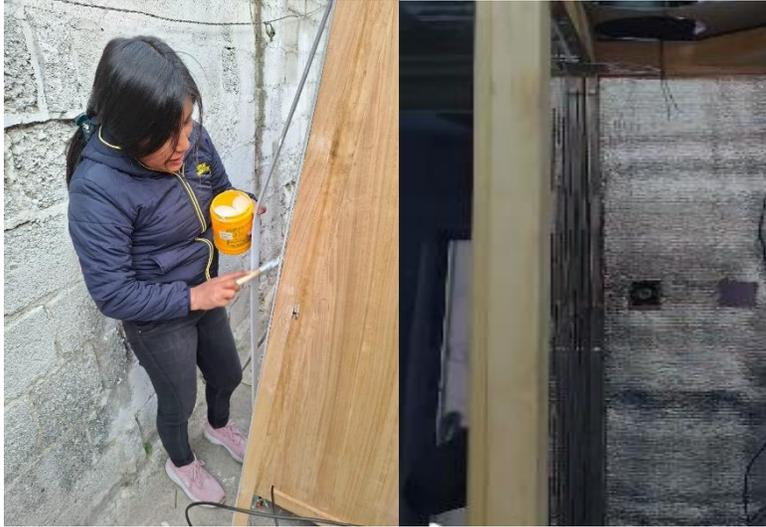
Una vez impermeabilizado toda la estructura se procedió a instalar el elemento calefactor y componentes ventiladores en la estructura interna del secador.
