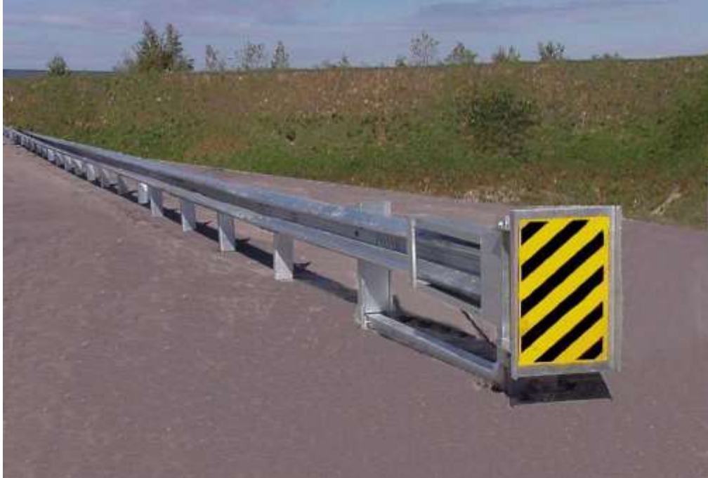
Figura 19: Terminal atenuador lateral traspasable
