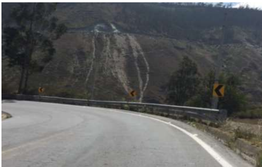
FOTOGRAFÍA 16: NO CUMPLE CON RADIO MÍNIMO.
