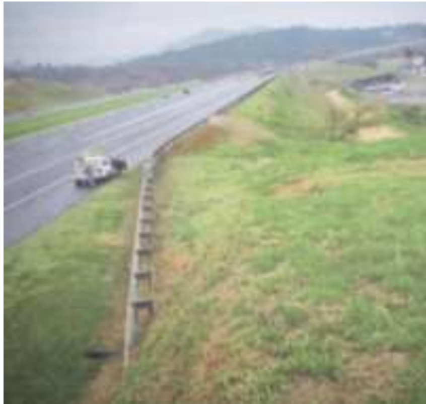
Figura 20: Terminal empotrado en talud
