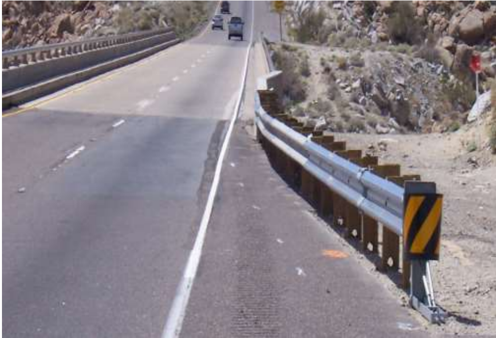
Figura 18: Terminal atenuador Redireccionables – no traspasables (RNT)
