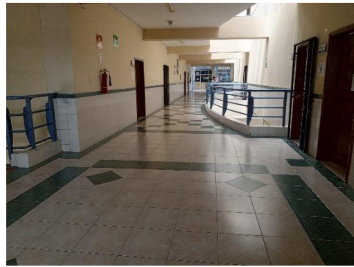
Figura 43. Pasillos panta alta
