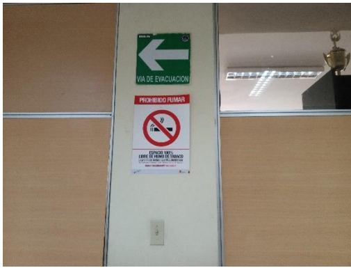
Figura 42. Vía de evacuación
