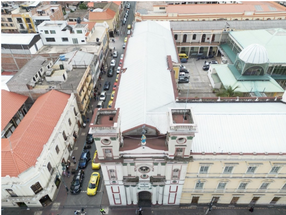
Figura 26: Imagen del techo captada con el dron
