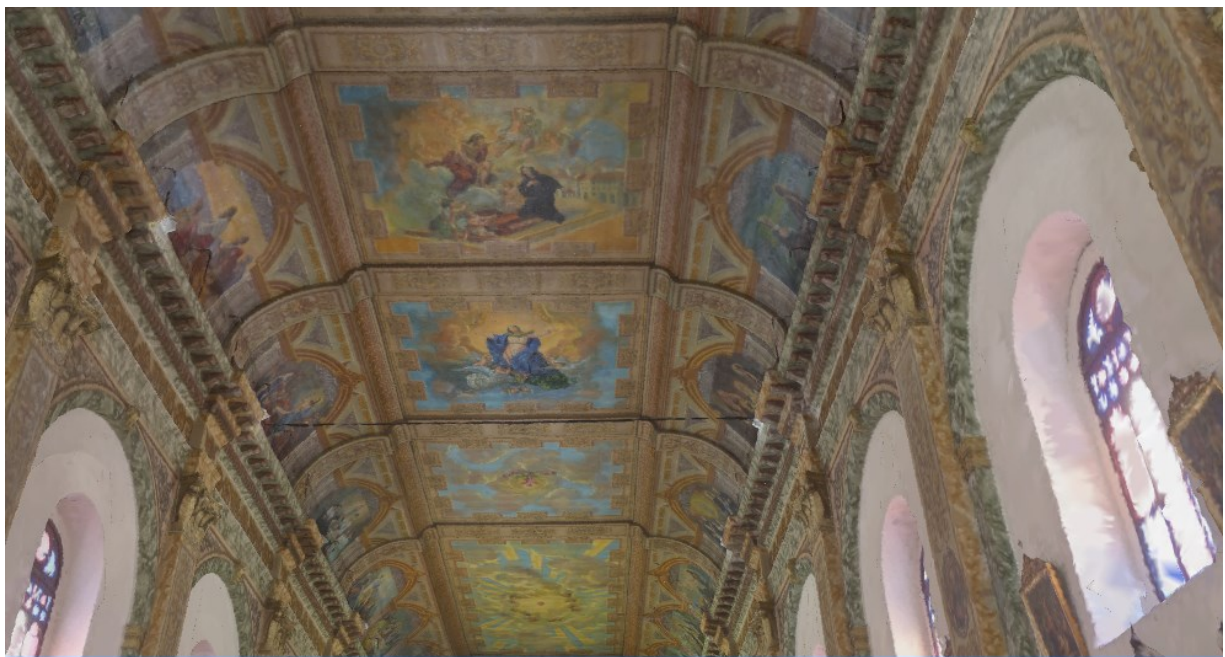
Figura 123: Pinturas Internas - Texturizado
