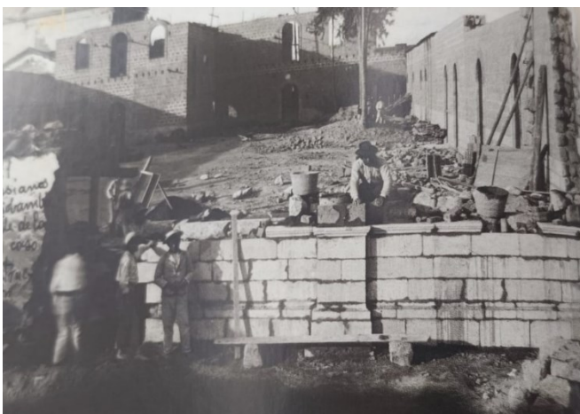
Figura 45: Construcción del Edificio del Colegio, 1921 Fuente: Archivo del Colegio Santo Tomás Apóstol
