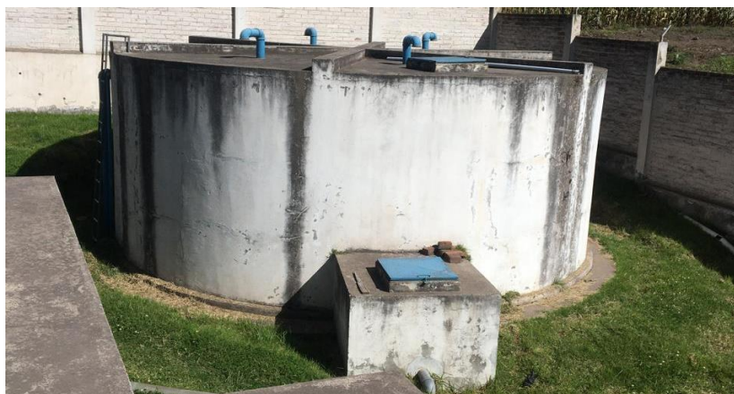
Figura 8 Tanque de reserva circular de la red San Juan Bajo.
