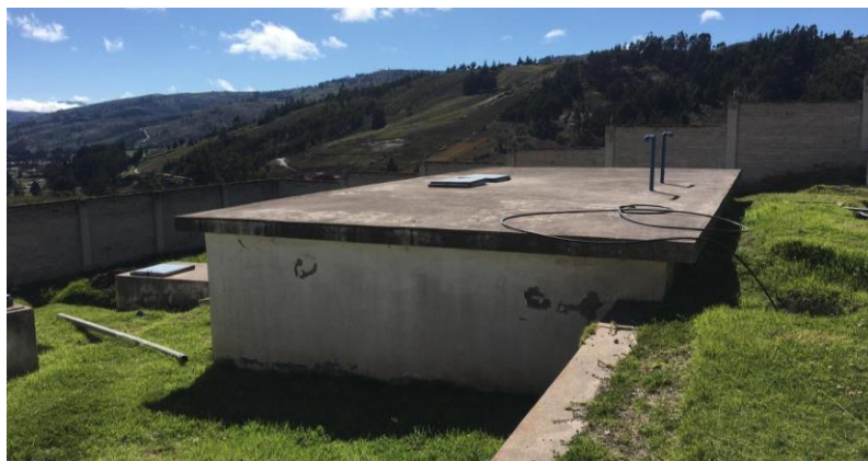
Figura 7 Tanque de reserva rectangular de la red San Juan Bajo.
