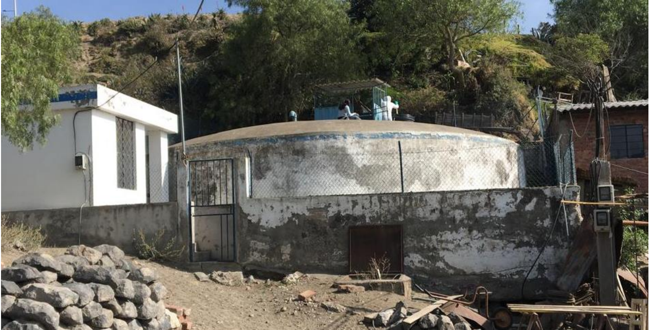
Figura 14 Tanque de reserva circular de la red La Inmaculada.
