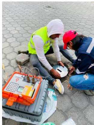
Anexo 13. Ensayo - Instalación del EDG.
