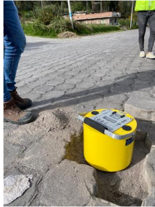
Anexo 11. Instalación del Geo-Gauge.
