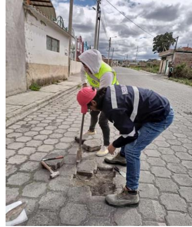
Anexo 3. Restauración de la perforación.
