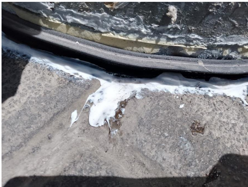
Figura 9. Relleno de juntas de adoquín
