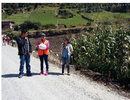
Fotografía 5. Indicaciones por parte de fiscalización al contratista de la obra de la vía San Francisco de Guayllabamba
