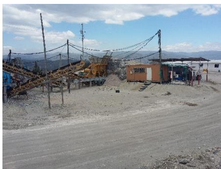
Fotografía 8. Planta de asfalto COVIPAL, vía Guamote-Pallatanga.
