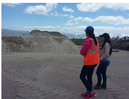
Fotografía 9. Inspección de los materiales usados en la planta de asfalto.
