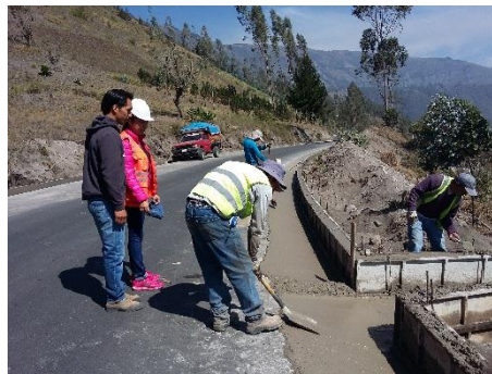
Fotografía 2. Fundición de cunetas, vía la Providencia
