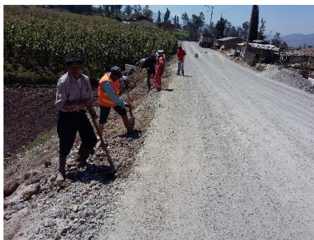
Fotografía 4. Inspección de los trabajos en la vía San Francisco de Guayllabamba.
