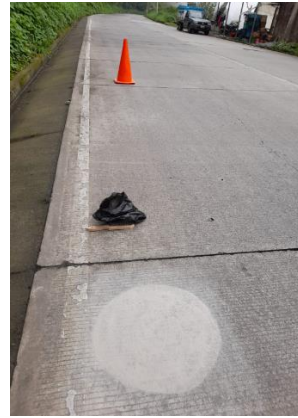
Anexo 11. Ensayo de macro texturas
