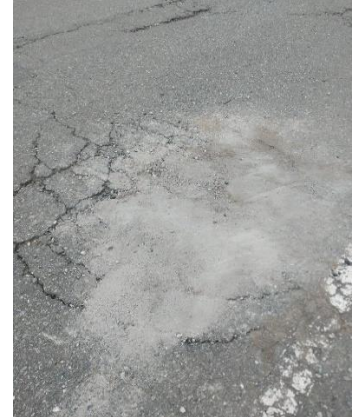
Anexo 3. Restauración de la perforación.
