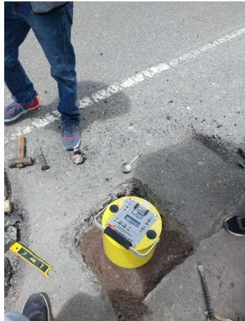
Anexo 11. Ensayo Geo gauge en pavimentos en buenas condiciones.
