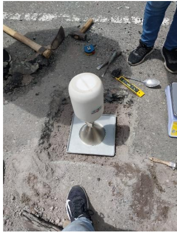
Anexo 10. Ensayo cono de arena.
