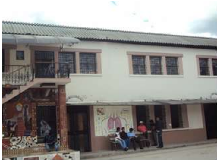
Pabellón de Internamiento – Sección Futuro
