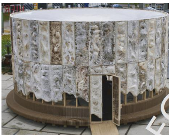
Figura 3. Construcción The Growing Pavillion. Adaptado de: (Elsacker et al., 2022)
