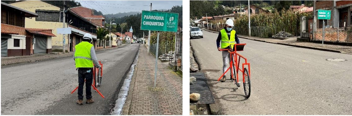
Foto 1: Ensayo de regularidad de la Vía Puente Quebrada Fornuyaico (Cuenca) - Chiquintad
