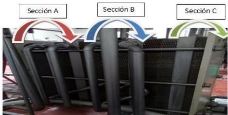
Ilustración 4. Secciones del intercambiador de calor
