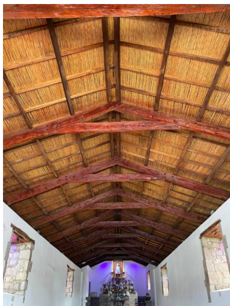
Figura 21 Nave central Iglesia de Balbanera
