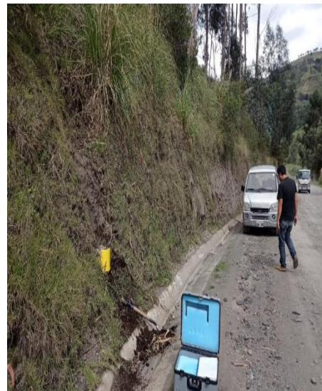
Anexo 5 Toma de datos al talud
