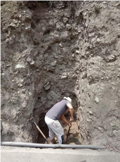
Anexo 7 Toma de muestra calicata 3 (Arena Agg)
