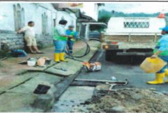
REPARACIÓN TUBERÍA FLEX 3/4" CALLE NAPO ENTRE CESLAO MARÍN Y 12 DE FEBRERO
