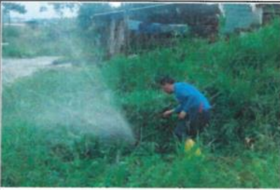
REPARACIÓN DE TUBERÍA DE PVC-P 63MM EN LA URBANIZACIÓN CENTRO AGRÍCOLA
