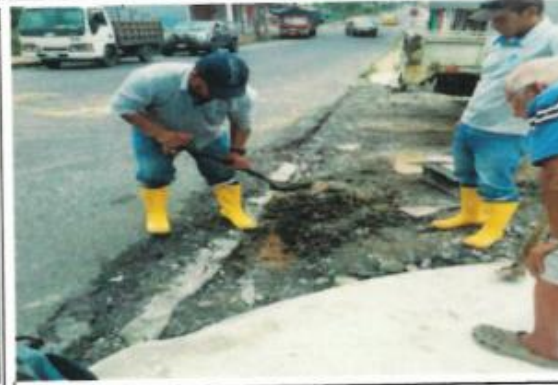
REPARACIÓN TUBERÍA PVC-P 50MM TENIENTE HUGO ORTIZ Y CUMANDÁ
