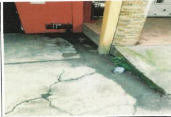
FUNDICIÓN DE ACERA POR REINSTALACIÓN DE ACOMETIDA HOTEL L Y F
