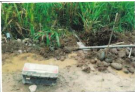
REPARACIÓN TUBERÍA PVC-P 63MM MARIANA DE JESÚS Y MANUELA SAENZ
