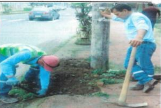
REPARACIÓN TUBERÍA FLEX 1/2" CALLE RÍO TIGRE Y CESLAO MARÍN
