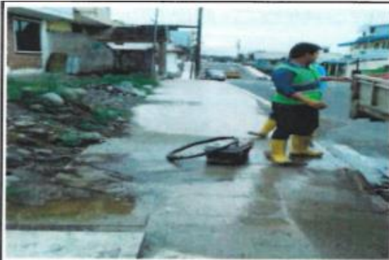
REPARACIÓN TUBERÍA FLEX 1/2" LUCINDO ORTEGA Y RODRIGO GRANJA
