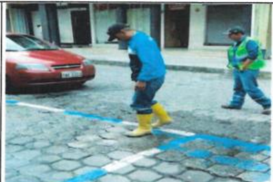
REPARACIÓN TUBERÍA FLEX 1/2" CALLE 27 DE FEBRERO Y CESLAO MARÍN
