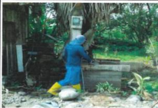
INSTALACIÓN DE ACOMETIDAS LOTIZACIÓN LALAMA I
