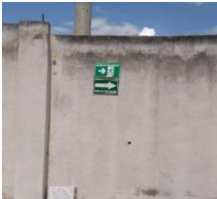
Figura 17: señalética de ruta de evacuación y salida de emergencia
