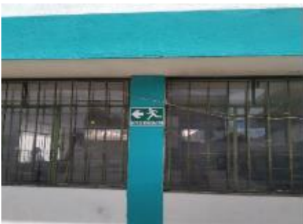
Figura 3: señalética ruta de evacuación sentido izquierda Bloque 2
