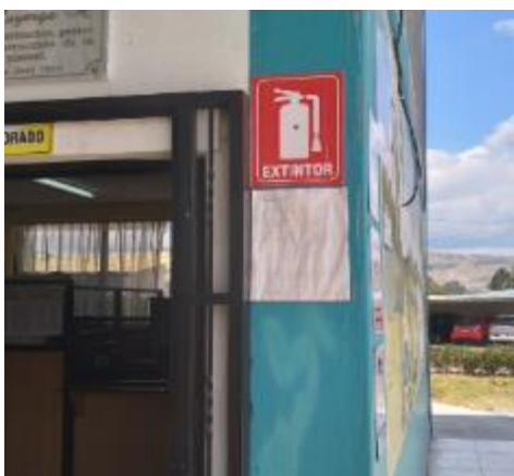
Figura 13: señalética de Extintor Bloque 1
