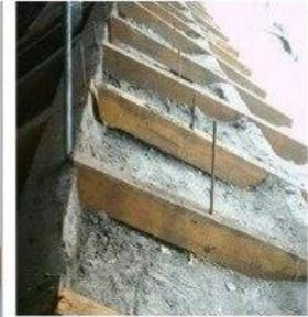
ANCLAJE DE CUBIERTAS A ARMADURA DE CABEZAS DE MURO
