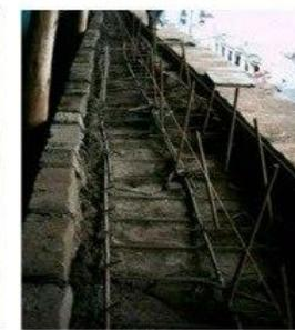
MICROPILOTAJE, PERFORACIONES CON BARRENOS SOBRE CABEZAS DE MUROS
