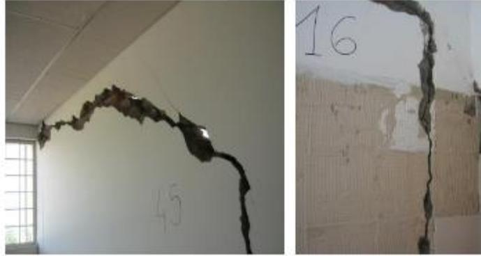
*Ilustración 9 Daños estructurales por arcillas expansivas*
