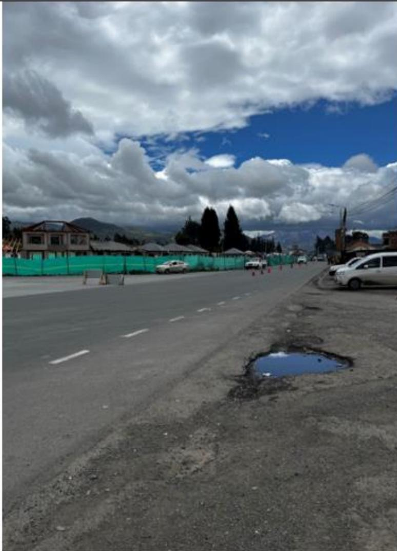
El estado de la via es muy malo, presenta baches, fisuras y patologias por la falta de mantenimiento lo cual causa daños a los vehiculos que transitan por la zona, ademas de que es una via de transito alto presenta vehiculos transitando a alta velocidad y las condiciones de la via no estan optimas lo cual podria ser causal de accidentes de transito.
