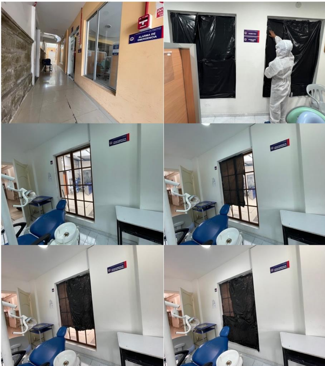
Fotografía 4. Collage de fotografías del proceso de sellado de ingreso de fuentes lumínicas.
