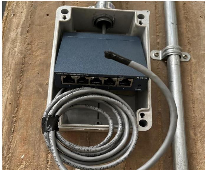
**Figura 25:** Instalación de Switch para comunicación Ethernet.
