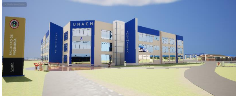
Figura 4.7. Facultad de ingeniería, bloque A.
