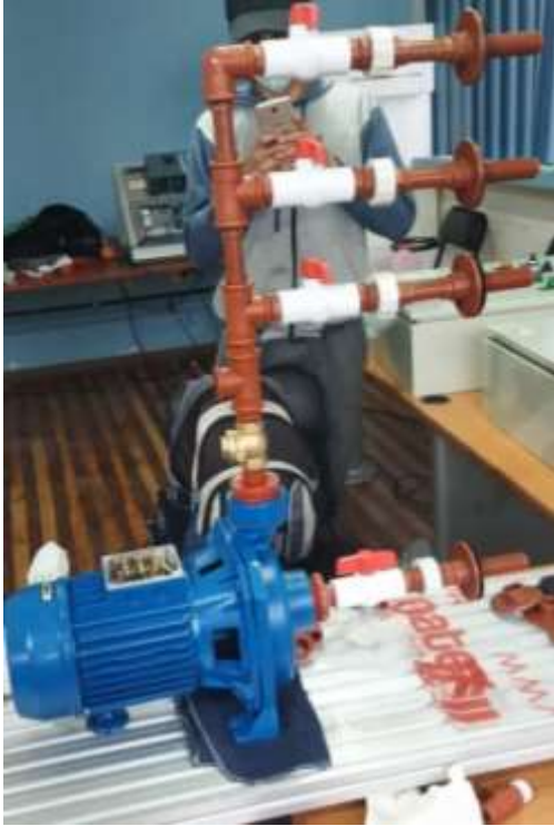
Figura 10 Parte superior del sistema de bombeo de agua utilizando accesorios de tubería de ½ pulgada
