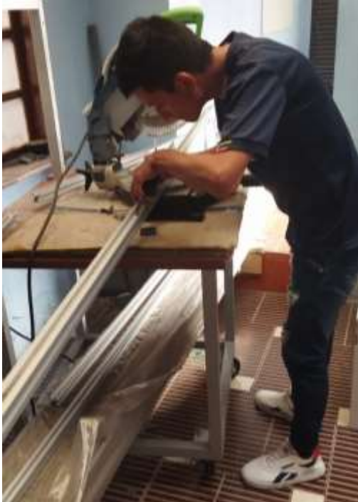
Figura 7 Elaboración de la estructura metálica
