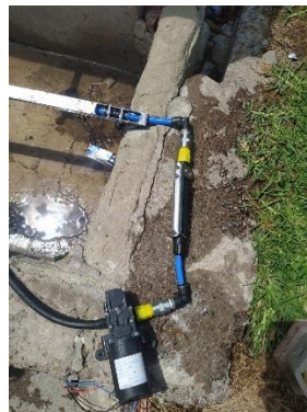
Figura 28. conexión de la bomba de agua a las barras pulverizadoras.
