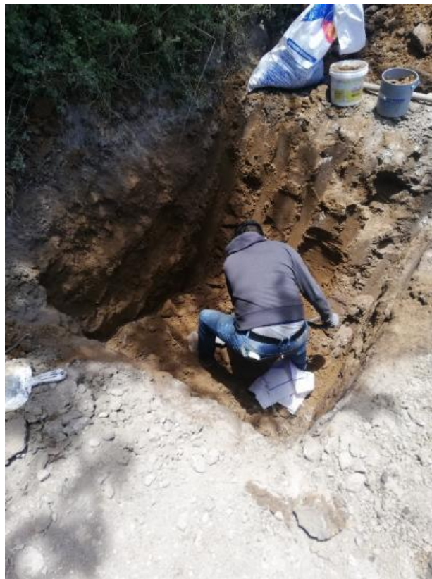
Anexo 29: Toma de muestras del suelo de la calicata.
