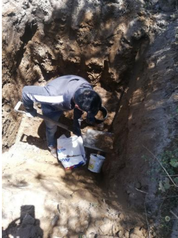
Anexo 28: Toma de muestras del suelo de la calicata.
