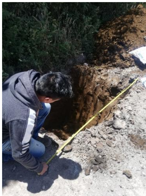
Anexo 27: Formación de calicatas.
