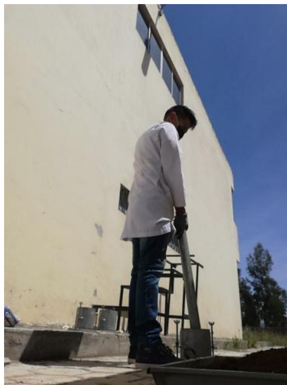
Anexo 53: Compactación del suelo con cal
