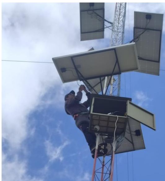
Figura 53. Arreglo de paneles solares instalado en sitio
