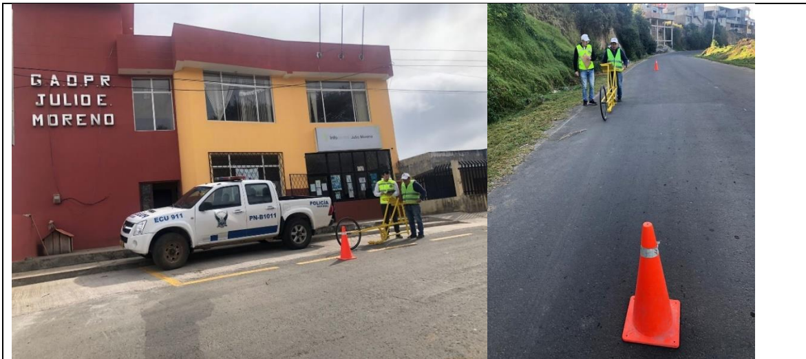
Foto 2 Ensayo de rugosidad realizado en la vía Guaranda-Julio Moreno
